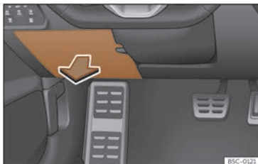
Fig. 203 No taboleiro de instrumentos do lado do condutor: tapa da caixa de fusibles.
